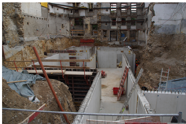
Vue du sous-sol en construction (direction rue)
