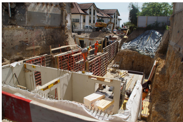
Vue du sous-sol en construction (direction home)
